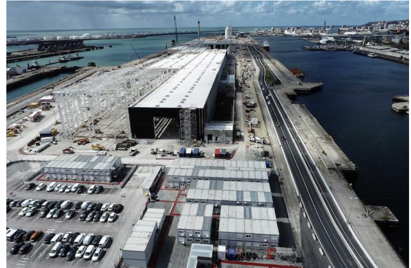
Plateforme d'accueil de l'éolien SIEMENS GAMESA, Le Havre
