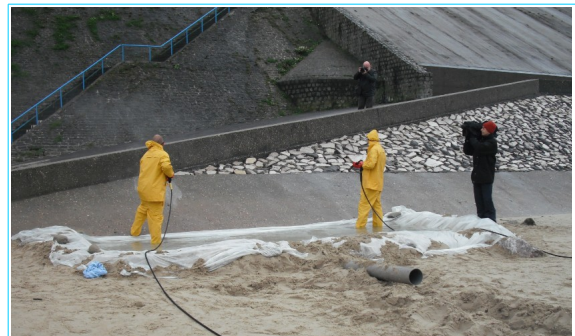
Atelier nettoyage d'enrochements
