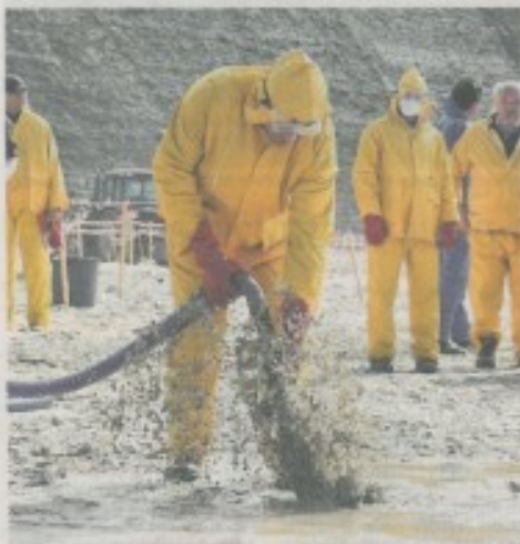
La technique du « flushing » consiste à injecter de l'eau dans le sable avec une forte pression pour faire remonter le pétrole qui s'est infiltré.
